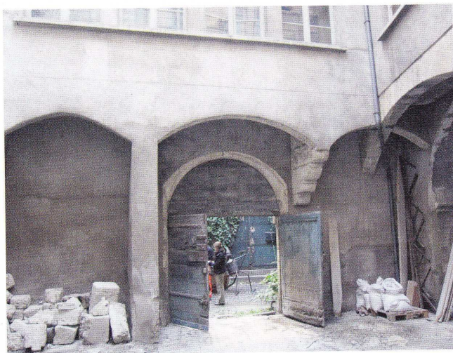
Revers du mur de clôture avec passage.
