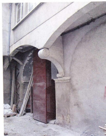
Galerie située sur le bâtiment longeant le rempart.
