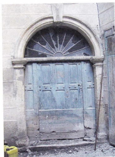
Porte d'entrée de l'escalier du XVII e siècle, ayant conservé une partie de sa menuiserie d'origine.
