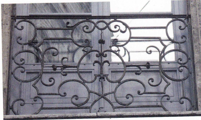
Garde-corps en ferronnerie.
