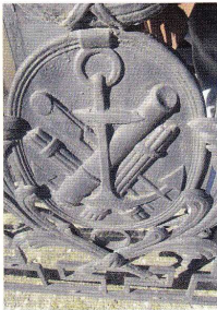
Garde-corps sur cour.
